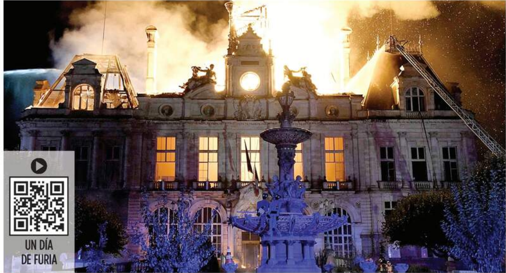
Manifestantes prendieron fuego al edificio del Ayuntamiento en Limoges, que data de 1876.
